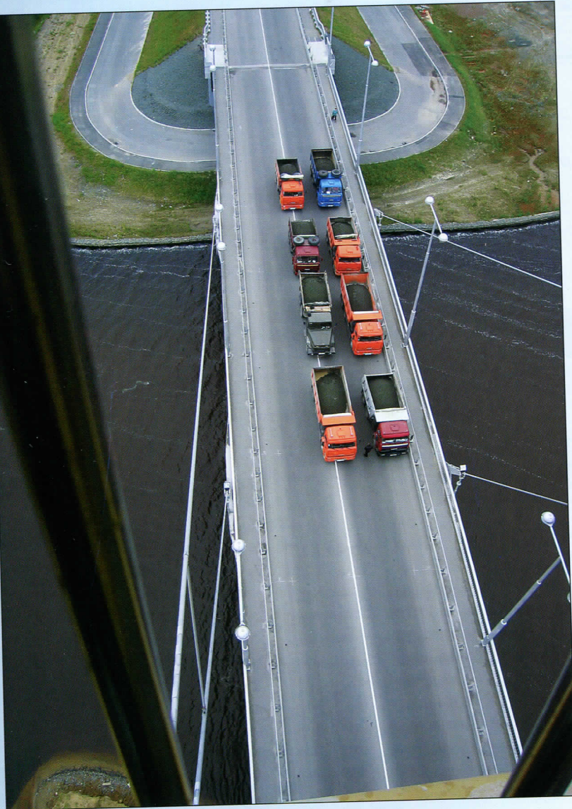
Рис. 5. Статические и динамические испытания моста
