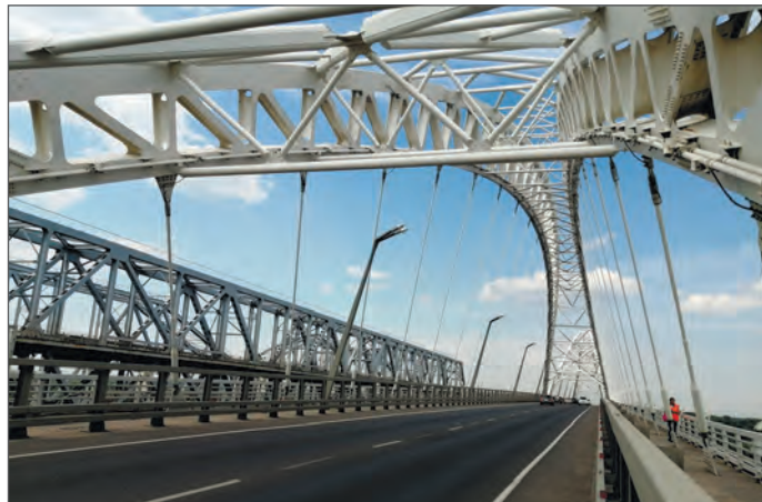
Рис. 2. Вид на проезжую часть арочного пролетного строения
