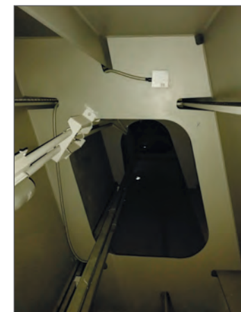
Рис. 5. Затяжка п.с. с акселерометром
