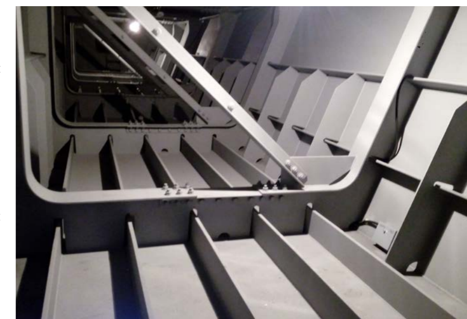
Рисунок 3. Пролетное строение с датчиками
